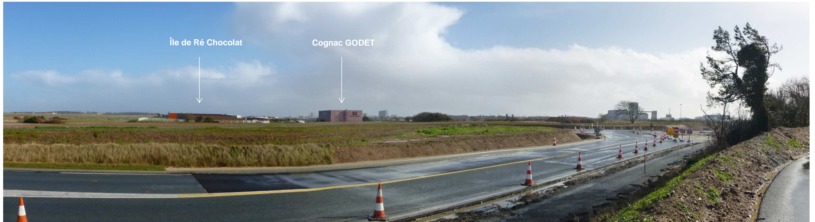
Photo 1 – Vue Ouest depuis la RD106
