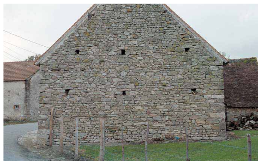
Pignon de granite et toit de tuiles à Cromac (Haute-Vienne)
