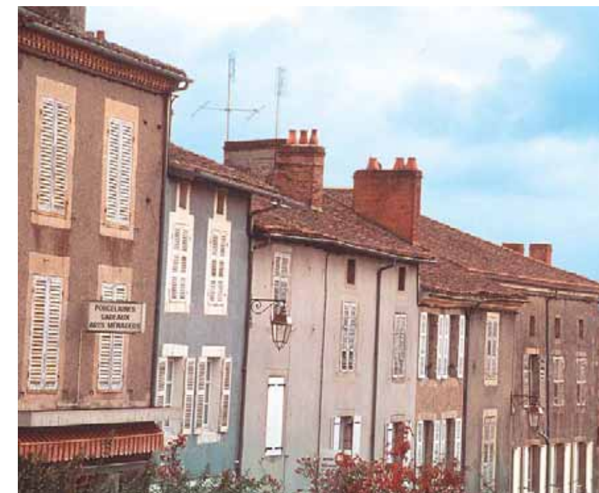
Façades enduites et jeu de toitures à Bellac (Haute-Vienne)
