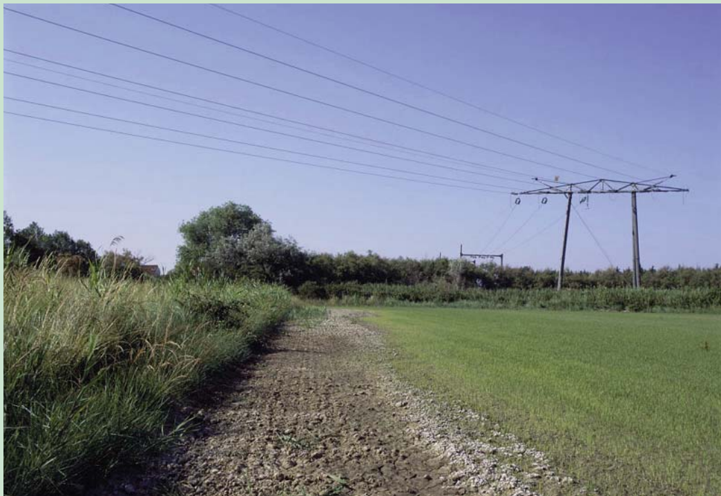
La ligne HT Roure-Picégou au-dessus de la Camargue, Bouches-du-Rhône
