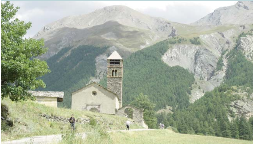
Zone de protection de l'église de Maurin, Saint Paul sur Ubaye, Alpes de Haute-Provence
