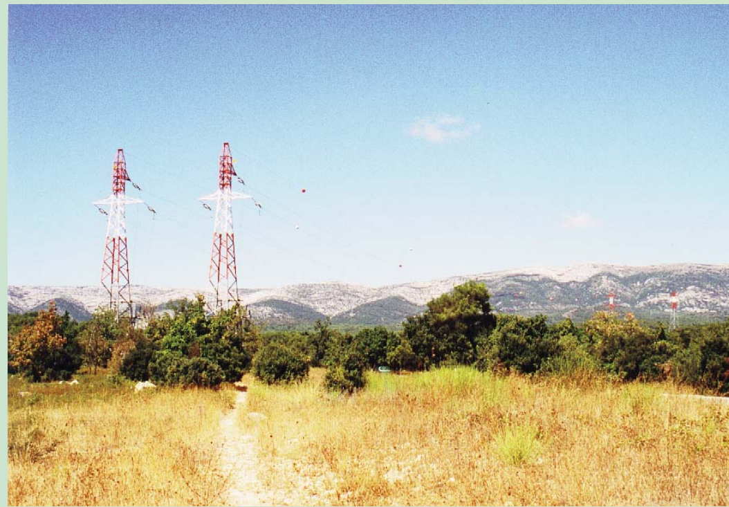
Ligne THT aux abords de l'aéroport du Castellet, Var
