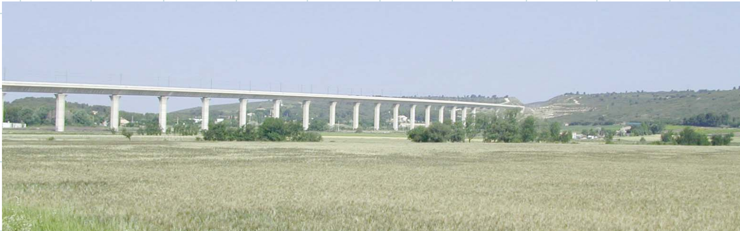
La topographie initiale de la colline du Ponteils, entaillée par deux anciennes carrières, a été restituée par comblement à l'aide des déblais issus du passage en tranchée de la ligne du TGV, Plaine d'Eguilles, Bouches-du-Rhône
