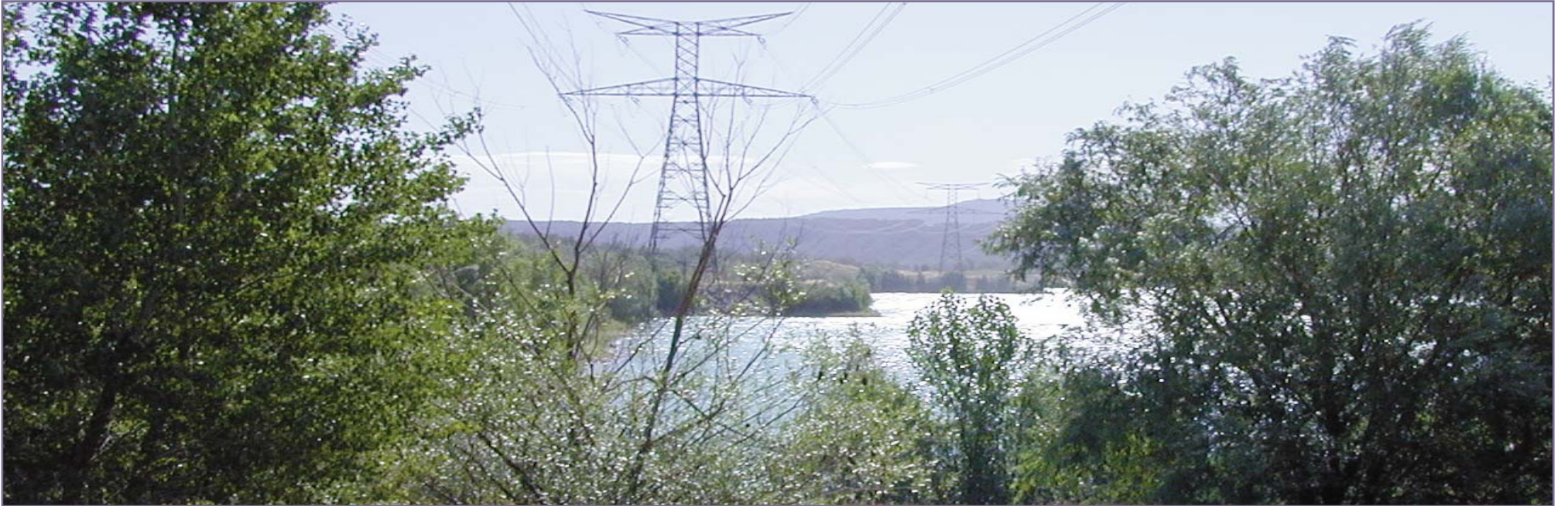
Tranchée partiellement végétalisée sur la ligne THT de Durance à Peyrolles, Bouches-du-Rhône
