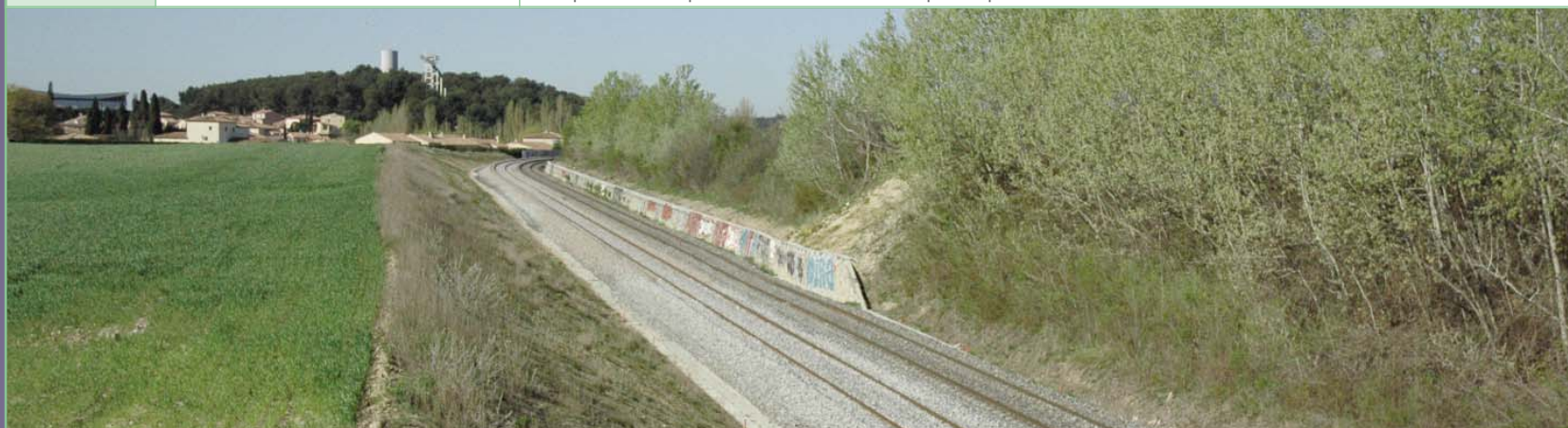
La ligne Marseille Gardanne en cours de rénovation en avril 2007 : coupure spatiale et visuelle à la traversée du plateau de la Malle, Bouches-du-Rhône
