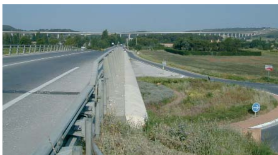
Le viaduc du TGV et la RD8 à Eguilles, Bouches-du-Rhône
