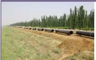
Chantier de pipeline à Istres, Bouches-du-Rhône
