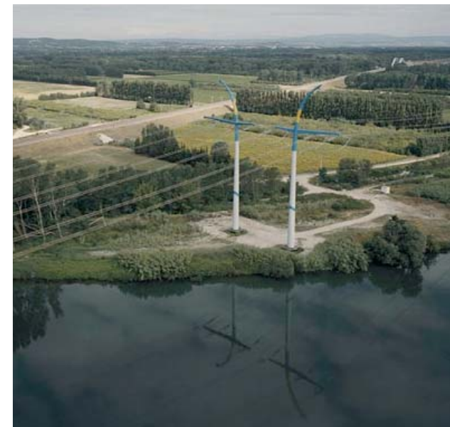
La ligne THT Tavel-Tricastin à la traversée du Rhône La qualité paysagère de la plaine bocagère du Rhône et la proximité de la ligne du TGV Méditerranée qui offre des vues sur la ligne électrique ont amené à concevoir un pylône spécifique à ce secteur pour une meilleure insertion dans le site.
