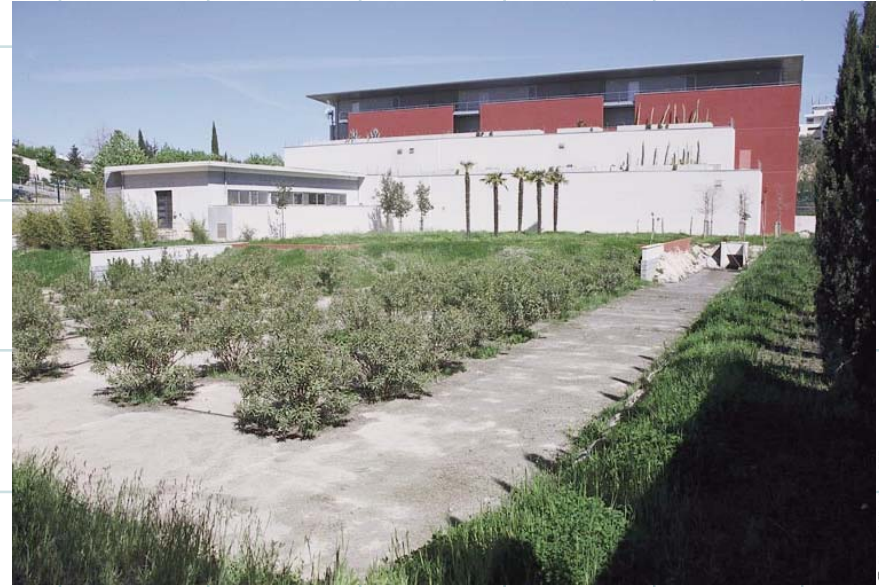
Exemple de qualité architecturale et d'accompagnement paysager pour un poste de transformation implanté à Antibes, Alpes-Maritimes
