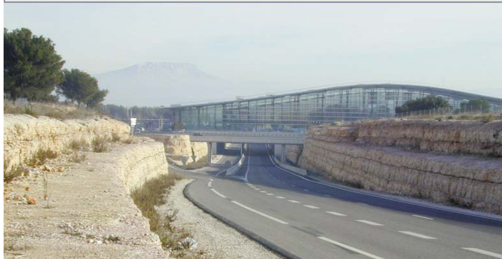
Le parti d'aménagement de la gare d'Aix, avec les tracés affirmés en tranchées des passages routiers et de la voie ferrée, enjambés par l'architecture harmonieuse de la gare, compose un ensemble paysager remarquable sur le plateau du Grand Arbois, Bouches-du-Rhône
