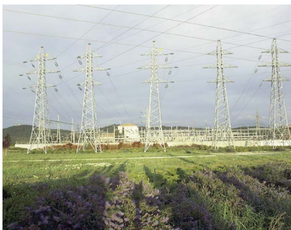
Poste transformateur à Jonquières, Vaucluse
