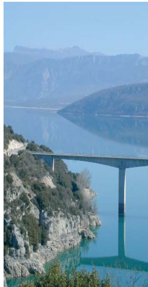
Un paysage créé, le lac retenue de Sainte-Croix enjambé par un viaduc : un ensemble harmonieux dans le paysage montagnard du Verdon, Alpes de Haute-Provence
