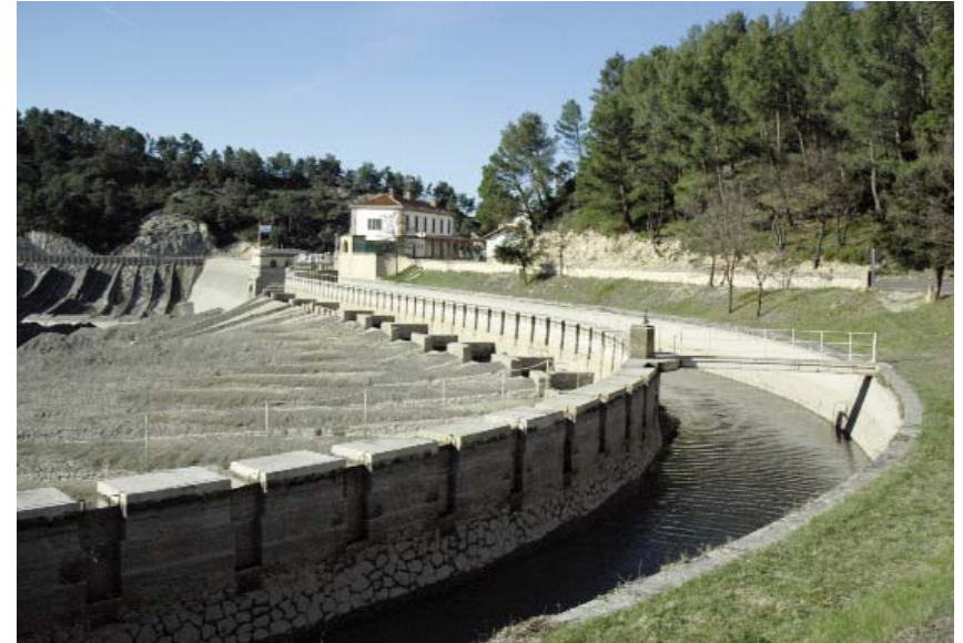
Le bassin de Saint-Christophe à l'étiage pour son dévasage : un ouvrage du XIX ème siècle sur le canal de Marseille, Bouches-du-Rhône
