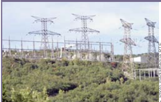
Poste électrique en milieu boisé
