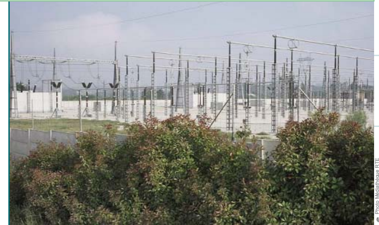
Aspect caractéristique d'un poste de transformation, à la forte image technique, de fort impact sur les ambiances paysagères
