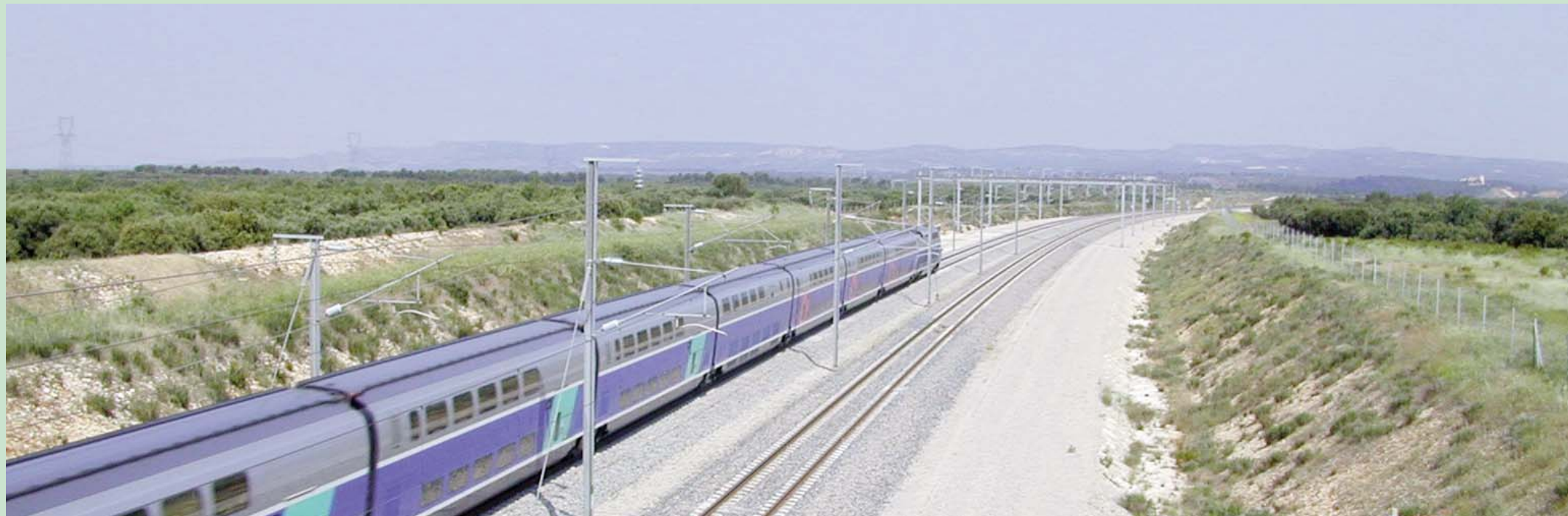
La ligne du TGV Méditerranée dans la traversée de la chaîne de la Fare, Bouches-du-Rhône
