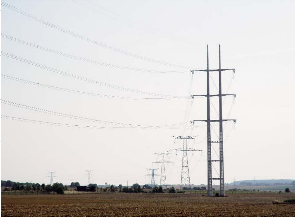
Au premier plan, le design du pylône Roseau améliore l'aspect de la ligne dans le paysage
