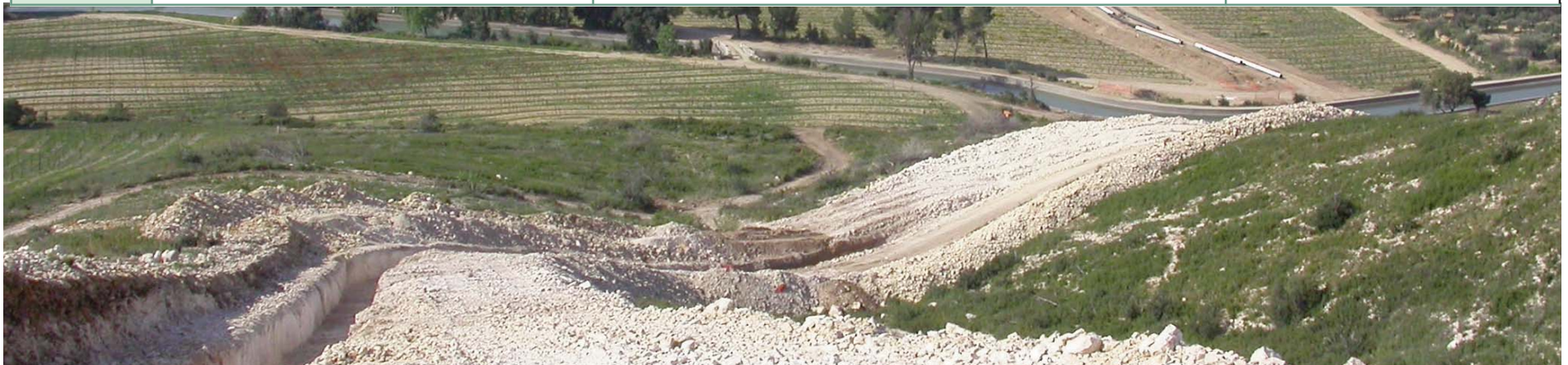
Chantier de pipeline au franchissement du versant et parcours dans la plaine à Coudoux, Bouches-du-Rhône
