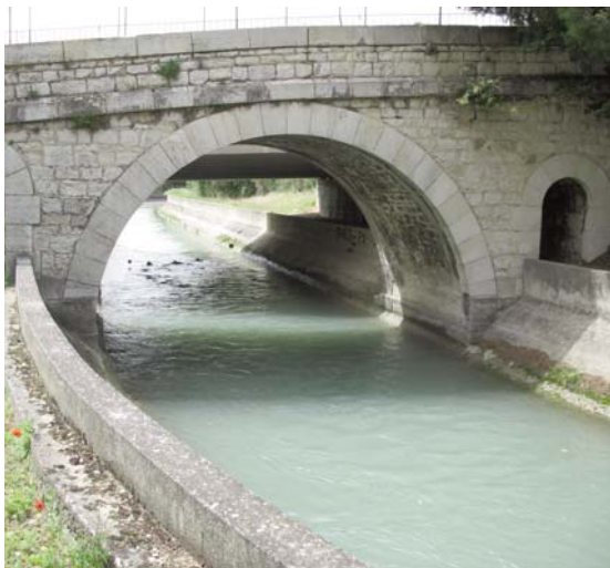
Pont enjambant le canal de Marseille, Bouches-du-Rhône
