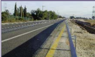
Sur le plateau du Grand Arbois : ancienne RD9 et ligne THT, Bouches-du-Rhône
