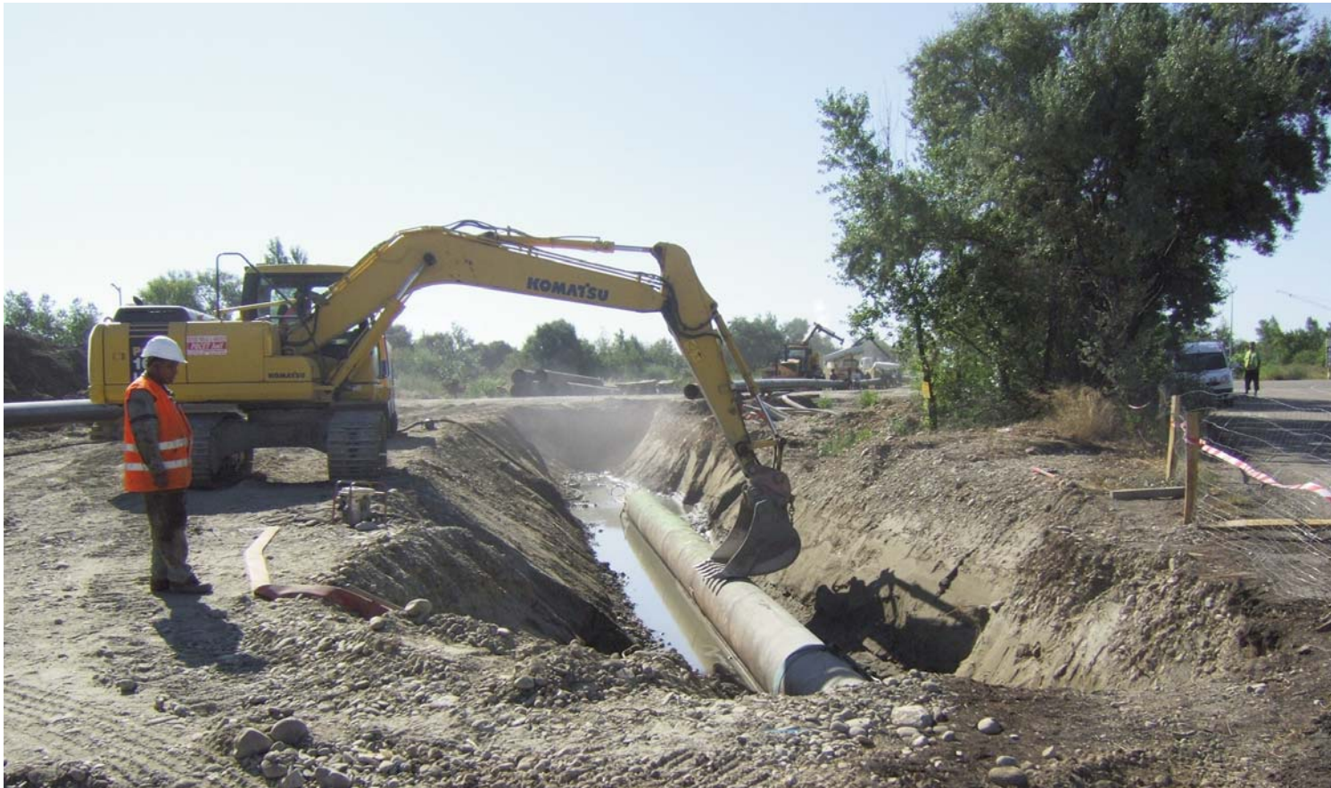
Arbre préservé à proximité d'une tranchée de gazoduc
