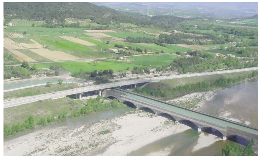
Le canal EDF entre Villeneuve et Oraison dans les Alpes de Haute-Provence. Complexité des ouvrages : aqueduc franchissant la Durançon, pont routier au-dessus du canal
