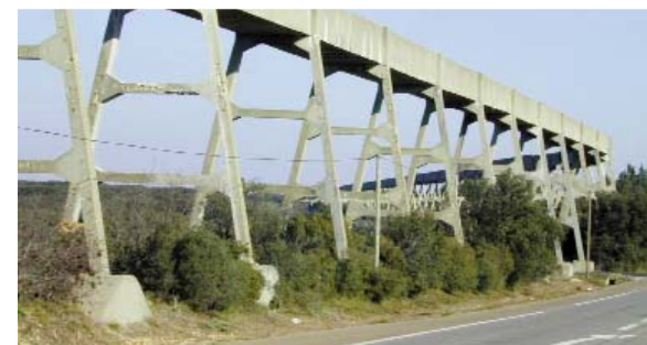
Passage en aqueduc d'une branche du canal de Craonne en Petite Crau, Bouches-du-Rhône
