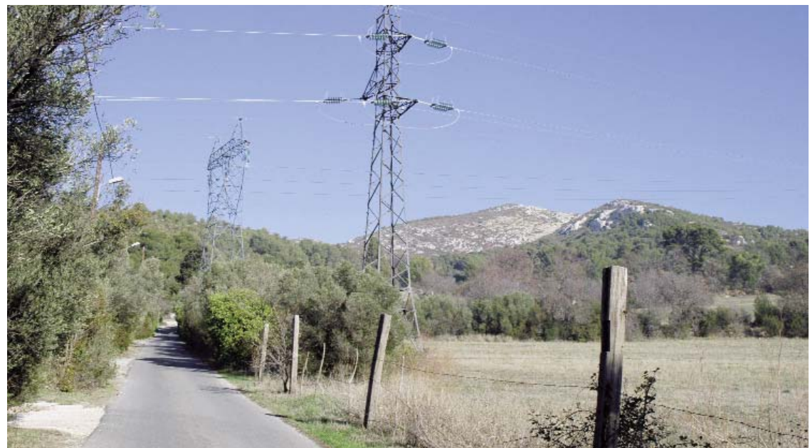
Ligne THT dans le site inscrit de Montespain à Allauch, Bouches-du-Rhône .
