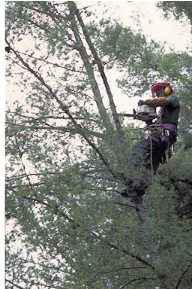
Gestion de la végétation aux abords d'une ligne électrique par une taille régulière et raisonnée
