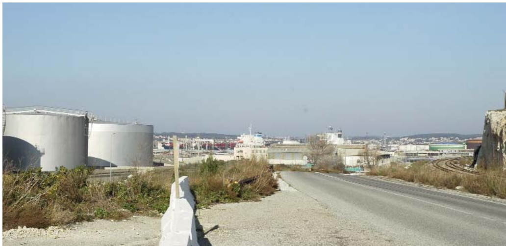
Paysage industriel, Lavéra, Bouches-du-Rhône
