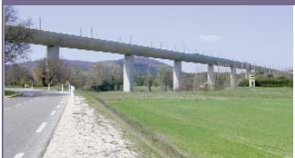
Viaduc du TGV et RD 22 à Vernègues, Bouches-du-Rhône
