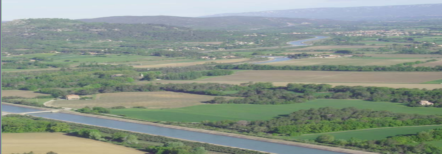
Le canal de Provence dans le vallée de la Durance au Puy-Sainte-Réparate, Bouches du Rhône. Source : DREAL PACA
