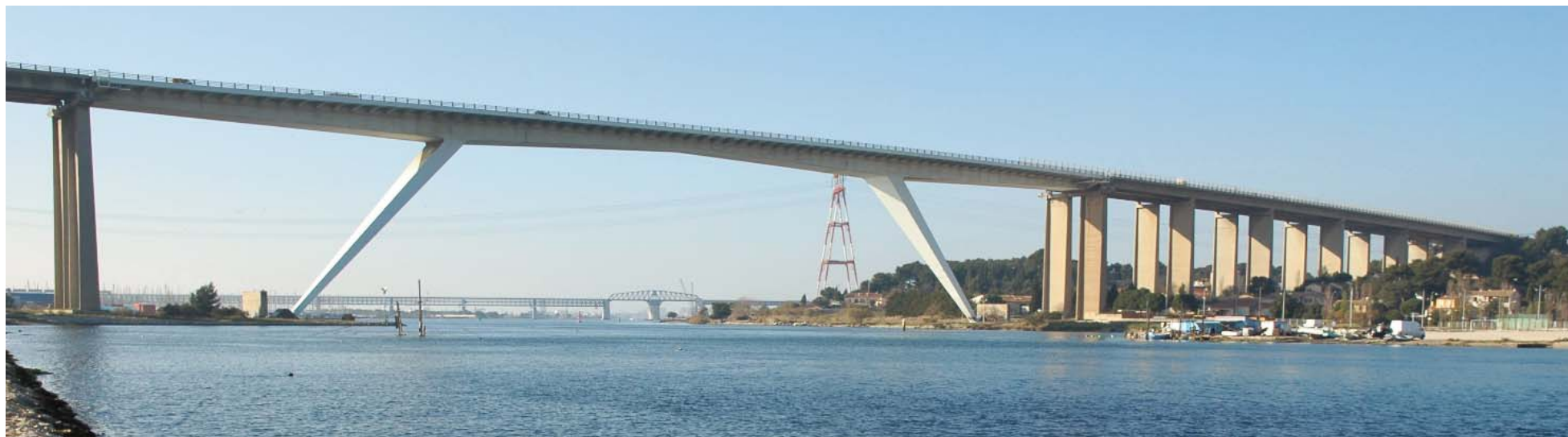
A Martigues, le canal de Caronte est franchi par le viaduc autoroutier au premier plan, par le viaduc ferroviaire à l'arrière-plan et par une ligne THT, Bouches-du-Rhône
