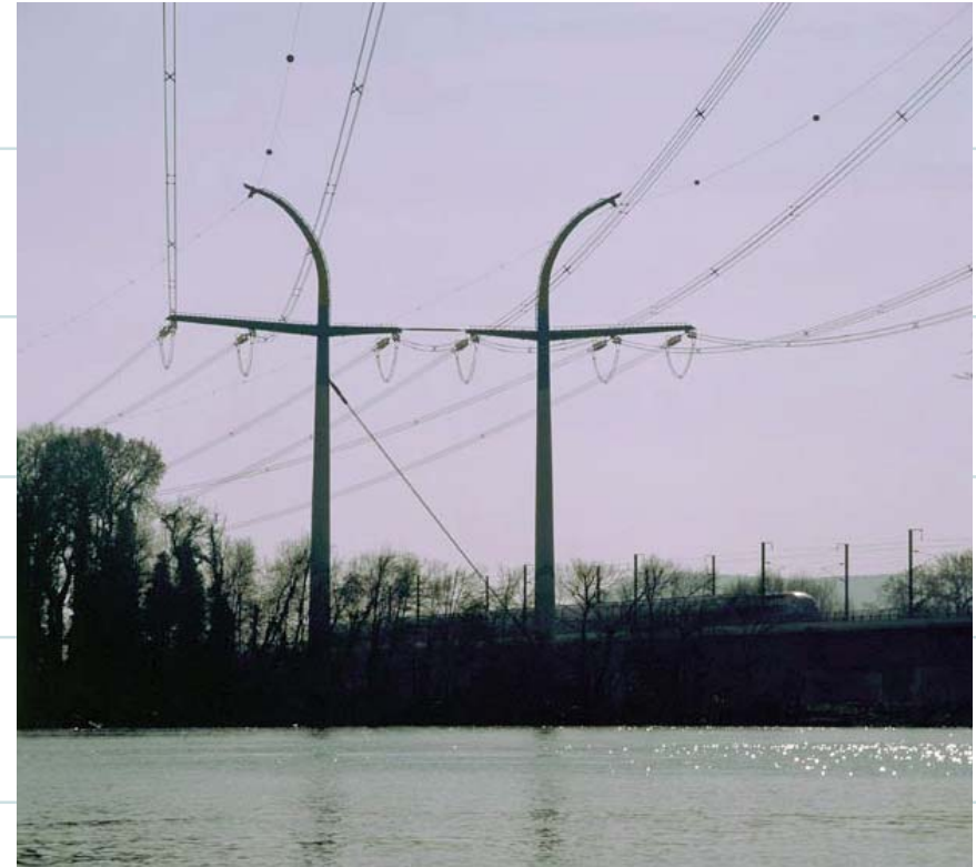
Pylône dessiné pour la ligne THT Tavel - Tricastin dans la traversée du site sensible des rives du Rhône
