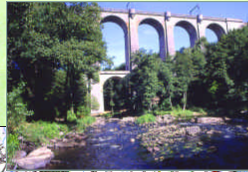
Viaduc de Rocherolles
