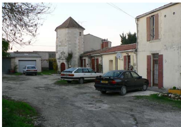
Le Logis de Pin muré - Rue Georges Clémenceau
