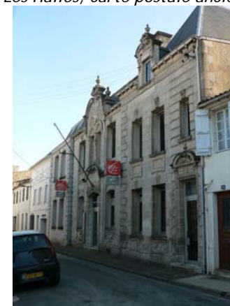
Rue Dubois Meynardie : ancienne Caisse d'Epargne, aujourd'hui la Maison des initiatives et des Services
