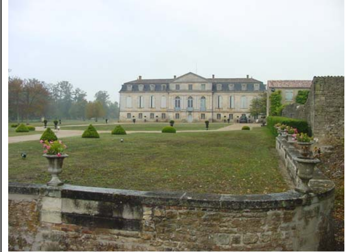
Château de la Gataudière Route de Nodas Façades, toitures, terrasse, salle à manger Cl.M.H. 1949 ; parc et fontaine Louis XVI I.S.M.H. 1948
