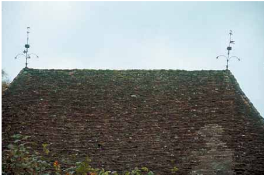
Toit de tuiles plates et épis de faîtage (Magnac-Bourg, Haute-Vienne)
