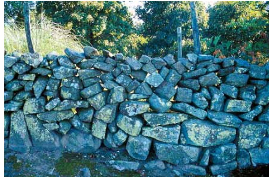
Exemple de mur en dentelle vers Toulx-Sainte-Croix (Creuse)
