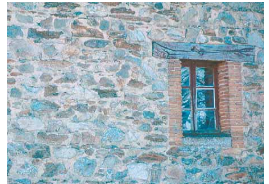
Détail de matériau d'un mur traditionnel à Bussière-Galant (Haute-Vienne) : mélange hétéroclite des matériaux rocheux disponibles sur place (roches métamorphiques), encadrement de fenêtre en brique, linteau en châtaignier
