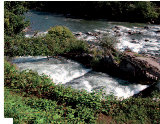
Aménagement pour les poissons migrateurs
