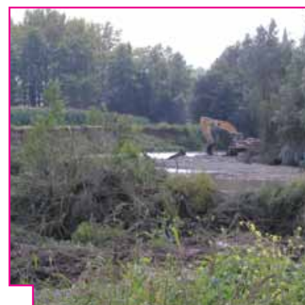
Travaux soumis à la Loi sur l'eau sur la Nive
