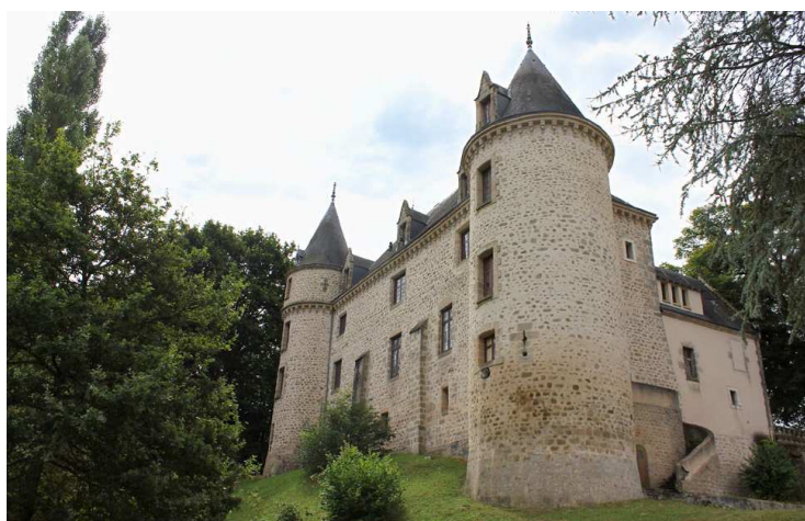
La façade nord
