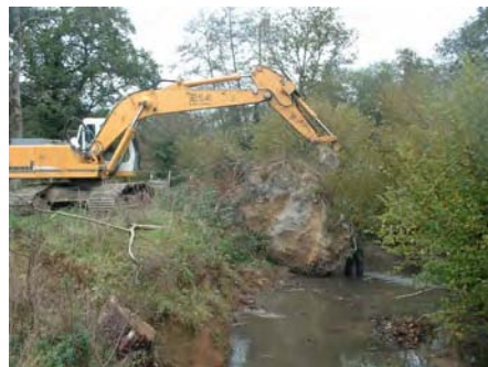
Photo 36 : 2 ème étape d'enlèvement mécanisée des embâcles
