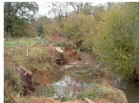
Photo 37 : 3 ème étape d'enlèvement mécanisée des embâcles
