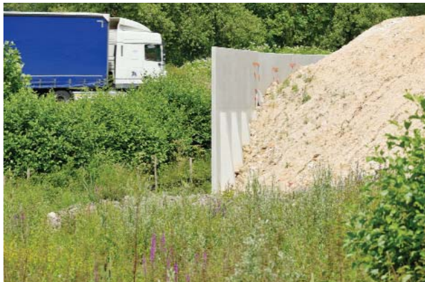
Mur de soutènement pour préserver la vallée du Trèfle
