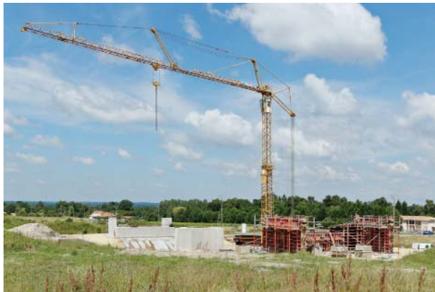
Travaux du PS 5 – juillet 2014
