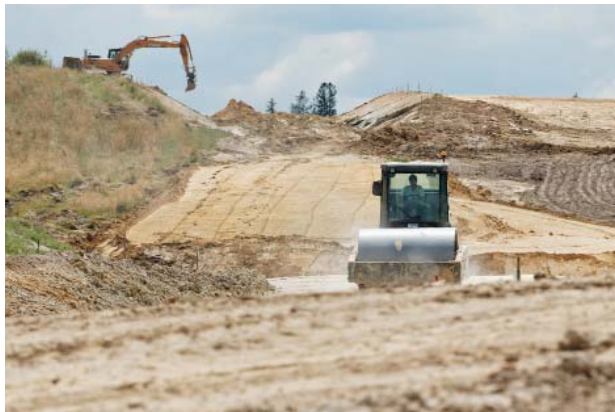
Travaux de la voie d'accès à St Bernard – juillet 2014
