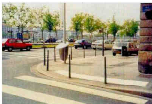
Aménagement réglementaire au passage piétons
