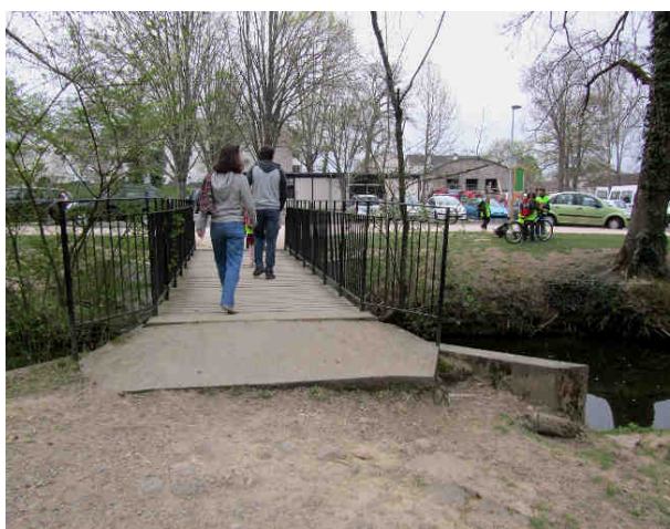
12- Petit pont qui enjambe la rivière l'Ousse des Bois
