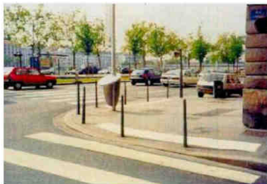
Aménagement réglementaire au passage piétons
