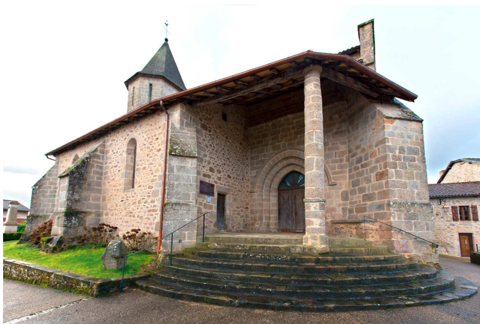
Eglise de Saint-Auvent
