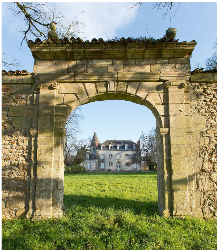
Vestiges du portail d'entrée du mur d'enceinte
