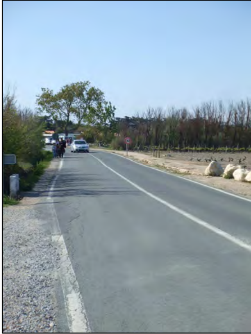
Photo 4 : Voie d'accès au site pour les piétons et les véhicules depuis l'aire de stationnement provisoire, cliché TBM
