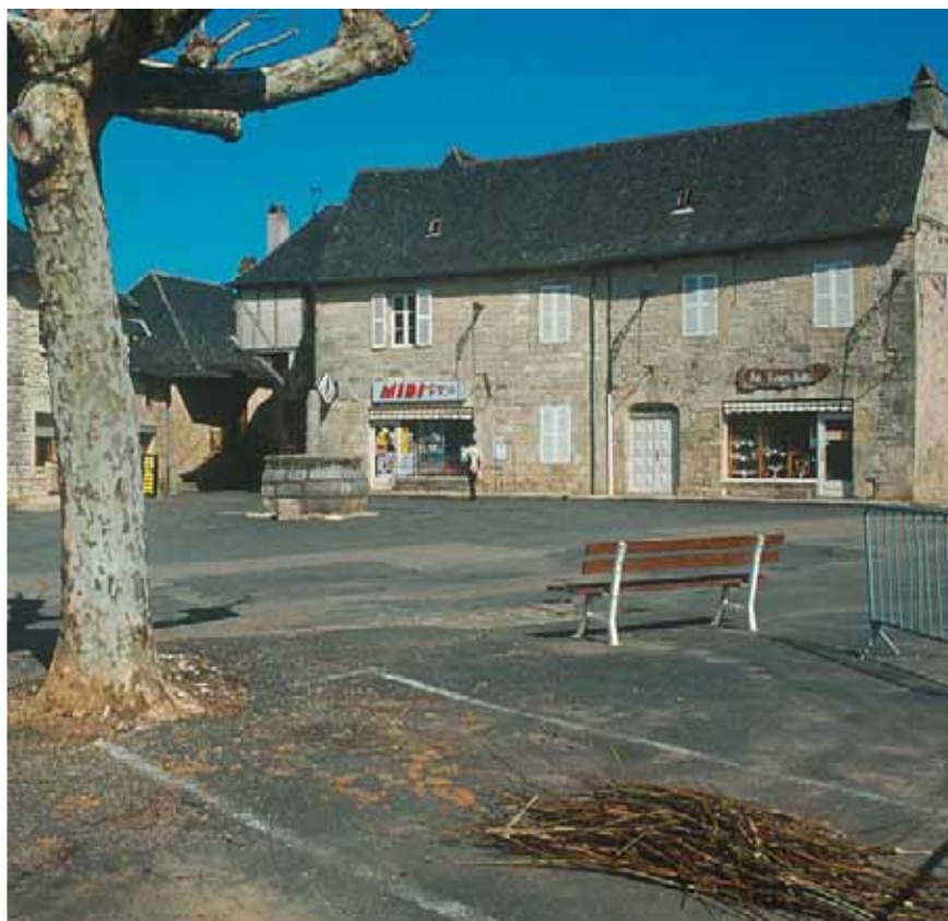
Bâti calcaire coiffé d'ardoises à Saint-Robert (Corrèze)
