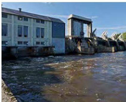
Centrale hydroélectrique de Jousseau à Millac sur la Vienne
