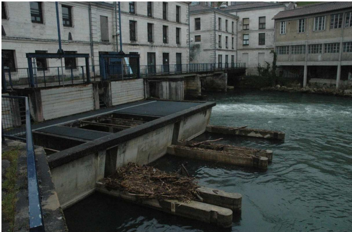
**Photographie 1 – Génie civil existant – Récupéré pour l'implantation des vis d'Archimède**
