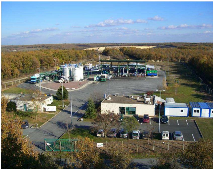
**SCORI Airvault** est notre plateforme de prétraitement spécialisée dans la fabrication de combustible liquide de substitution (CLS via fluidification de déchets pâteux avec des solvants).
