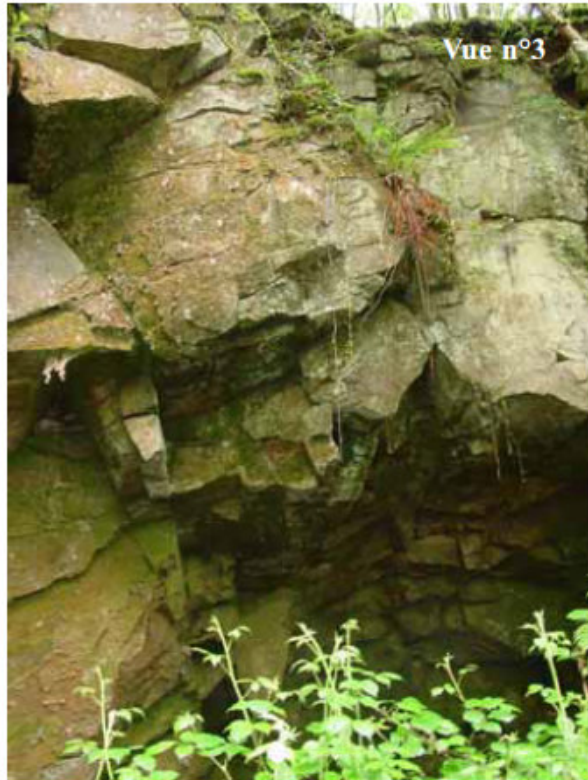
Photo n°3. Blocs situés à l'aplomb de l'entrée de la cavité
