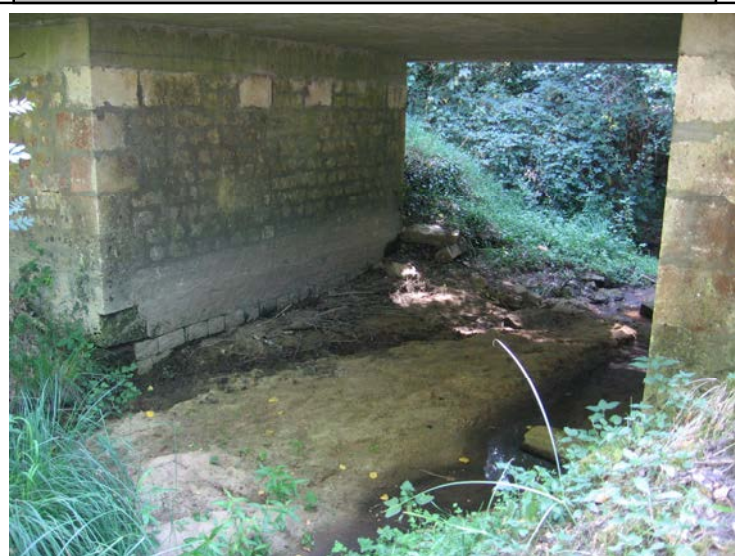
Photo de l'ouvrage/ Cours principal
