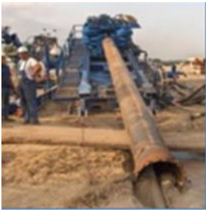
Forage dirigé Washover
