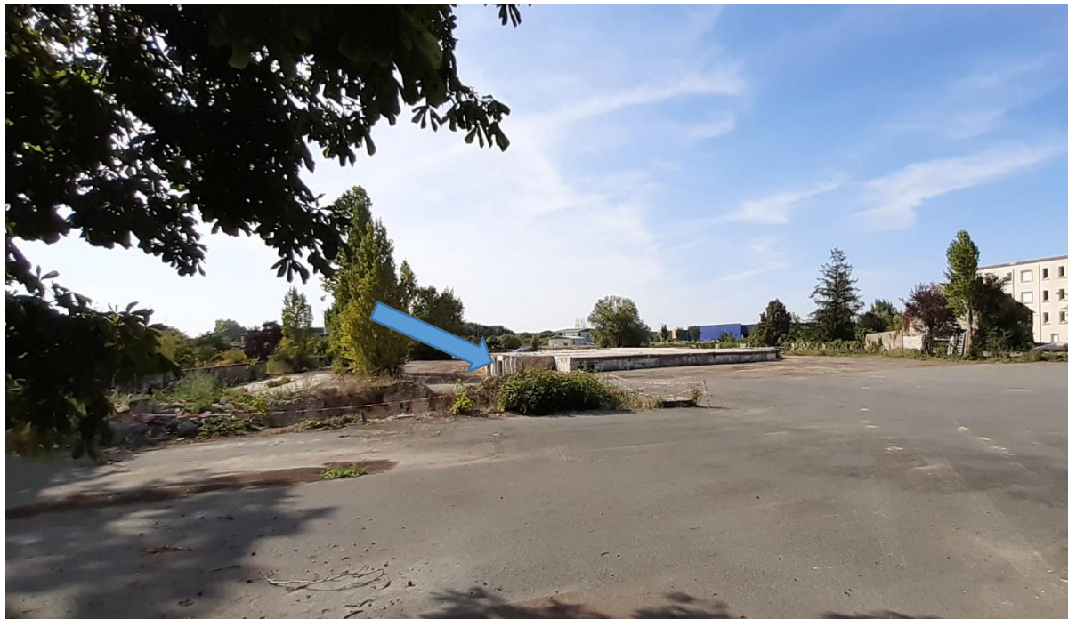
Figure 2 : friche industrielle de la STAR vue depuis l'avenue d'Argenson en septembre 2021 et accès au sous-sol (flèche bleue), à Châtellerault (86) ©LPO
