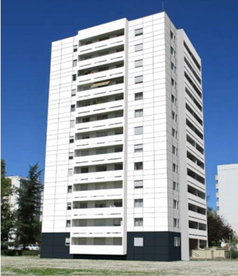
Figure 3 : Aspect projeté d'une Tour Rose après travaux
