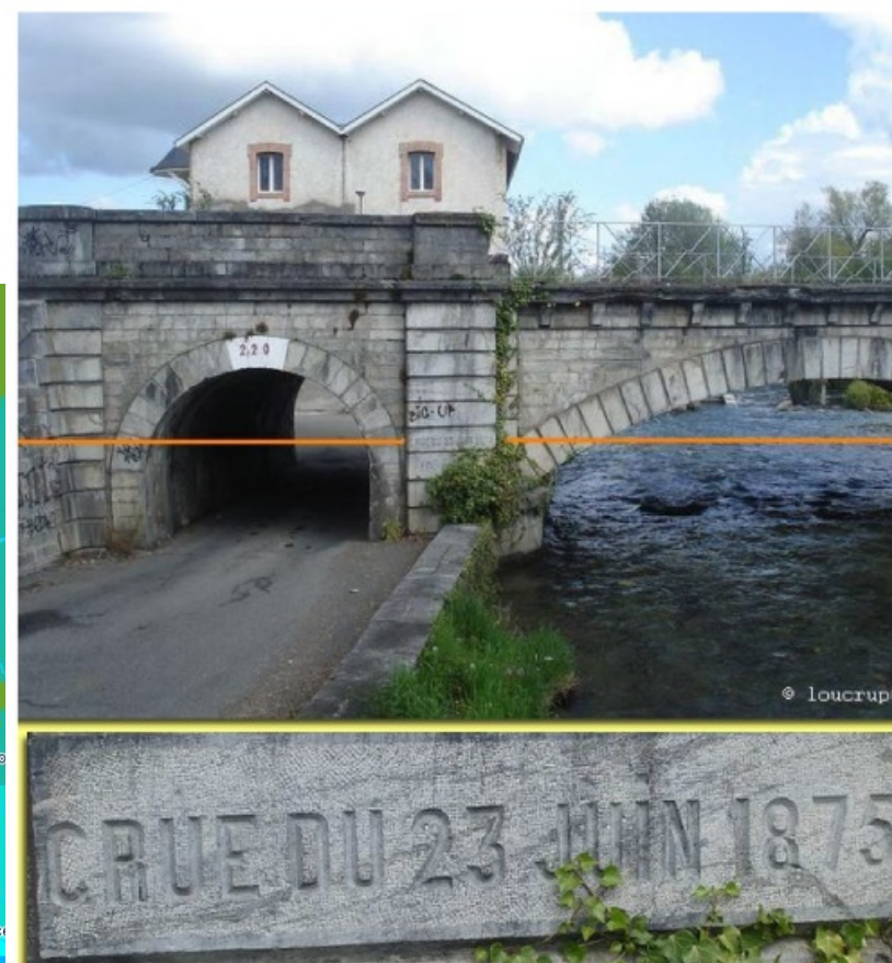
Pont de la voie ferrée à Bagnères
