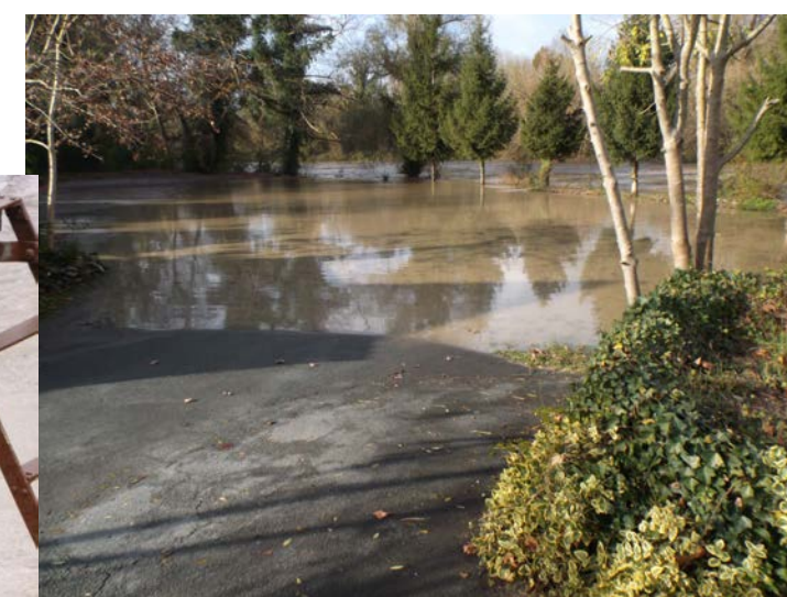
Abords de la station d'Escos en Novembre 2015
