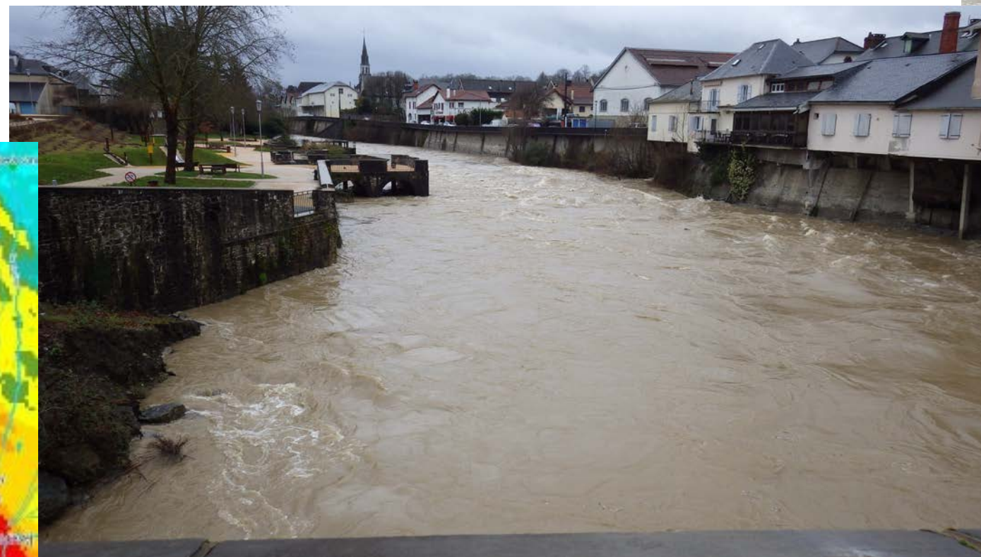
Vue depuis le pont du collège à Mauléon-Licharre (Février 2015)
