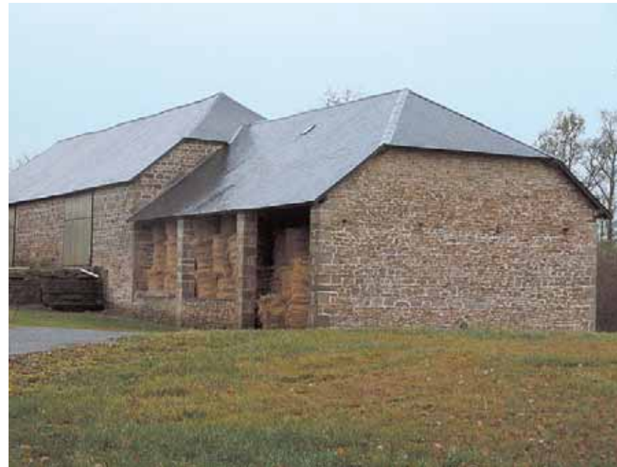
Les dépendances agricoles elles aussi sont réalisées en matériaux nobles
