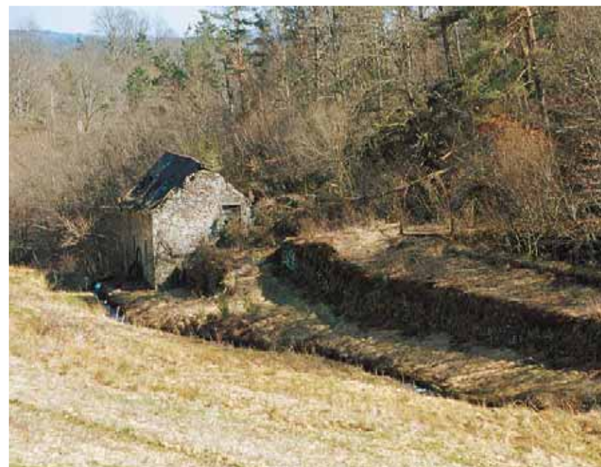
Ancien moulin à écluse à l'abandon (Saint-Hilaire-Foissac, Corrèze)
