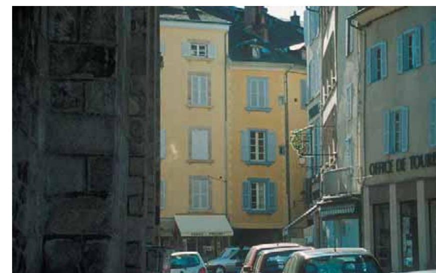
Un exemple intéressant de réhabilitation des façades à Tulle (Corrèze) : la ville est "rééclairée"
