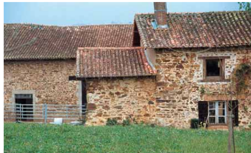
Murs de roches métamorphiques variées avec toit de tuiles canal
