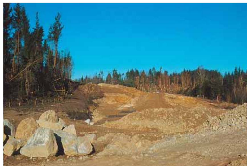
Les sols ocre mis à nu par le chantier de l'A 89, vers Ussel (Corrèze)
