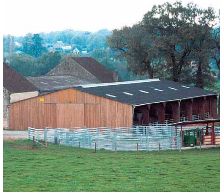
Utilisation du bois pour de grands bâtiments agricoles à Magnac-Laval (Haute-Vienne). Cet exemple montre à quel point le bois s'accorde bien, dans ses tonalités, aux granites, schistes et gneiss limousins
