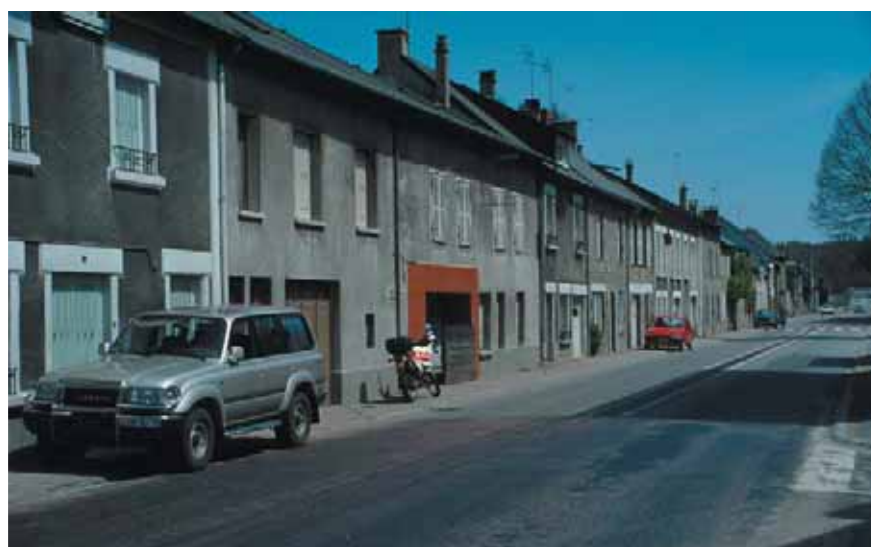
Des façades vieillies sur la N 89 à Saint-Angel (Corrèze)
