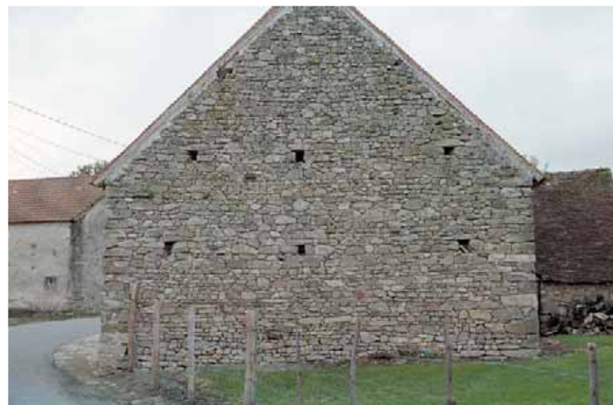
Pignon en granite : appareillage irrégulier (nord de la Haute-Vienne)
