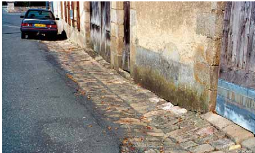
Caniveau en granite à Châtelus-Malvaleix (Creuse)
