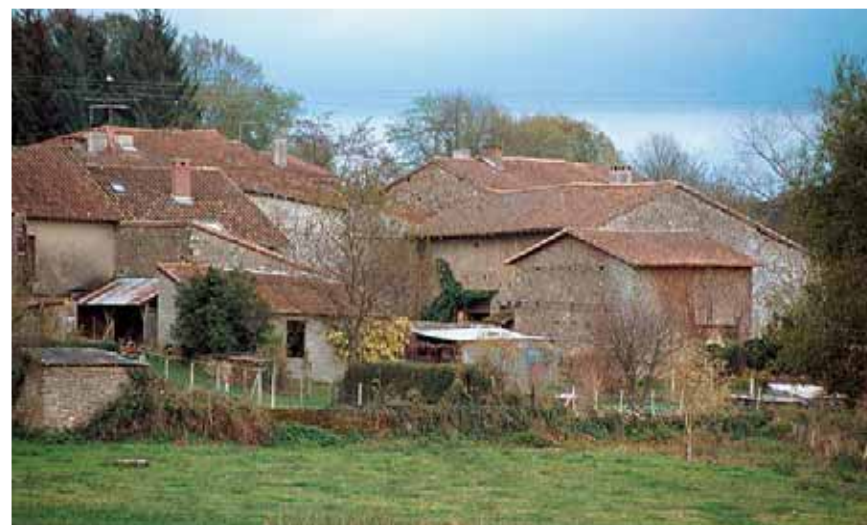
Un village des plateaux au sud-ouest de la Haute-Vienne
