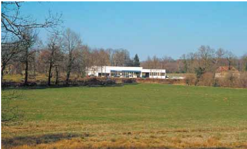
Bâtiment d'activité trop blanc dans le paysage entre Uzerche et Seilhac (Corrèze)
