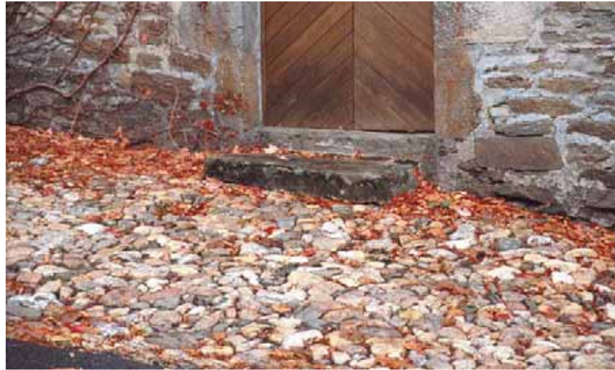
Caniveau construit à l'aide de galets à Coussac-Bonneval (Haute-Vienne)
