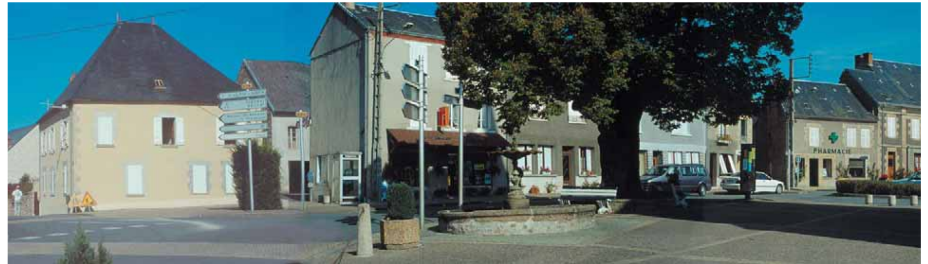
La place de l'église à Bussière-Dunoise (Creuse). A gauche, une façade refaite "rééclairer" l'espace public. A droite, le linéaire des façades vieilles, au ciment gris, qui mériteraient d'être reprises
