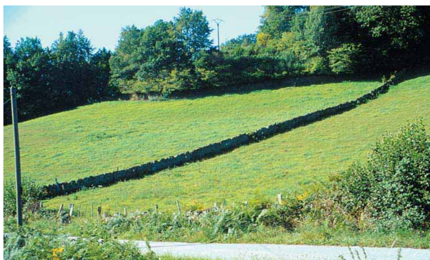
Mur de granite en pierres sèches séparant deux parcelles
