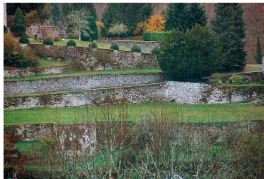
Murs de terrasses à Treignac (Treignac)
