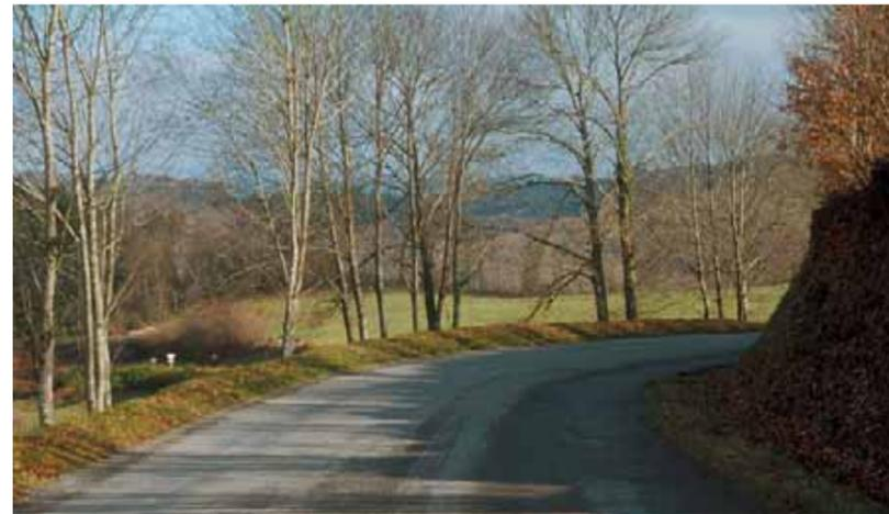
Le "coussinet enherbé" (appelé aussi merlon ou banquette par la D.D.E.) : un exemple intéressant de dispositif de protection en remplacement des traditionnelles glissières métalliques (vers Saint-Laurent-les-Eglises, Haute-Vienne)
