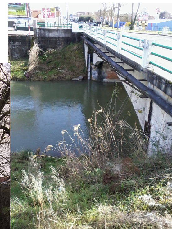
Aperçu de l'échelle limnimétrique de Tarbes-Echez
