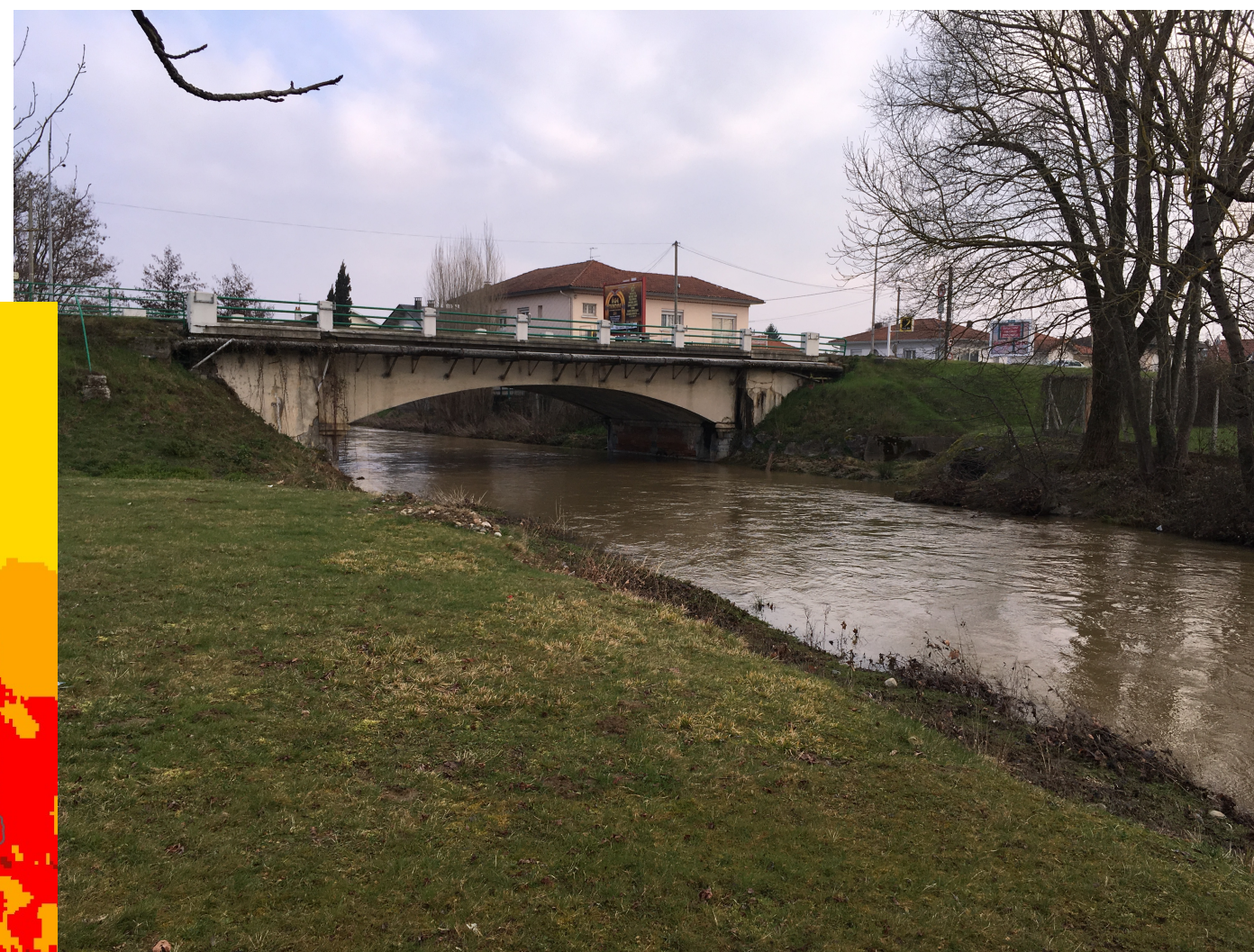
Vue de l'amont du pont de la station réglementaire de Tarbes-Echez
