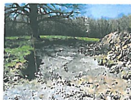
Mise en place d'une dalle béton
