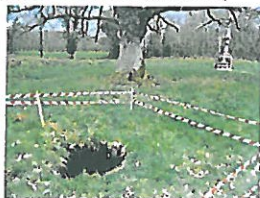
Affaissement de terrain
