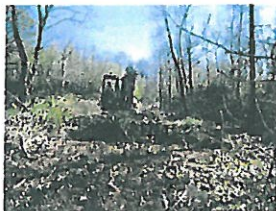
Travaux de débroussaillage
