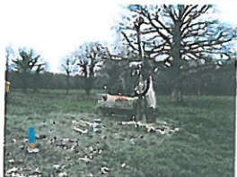
Réalisation des sondages
