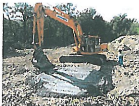
Réalisation d'un bouchon en béton armé (12 m 2 ) - puits P1
