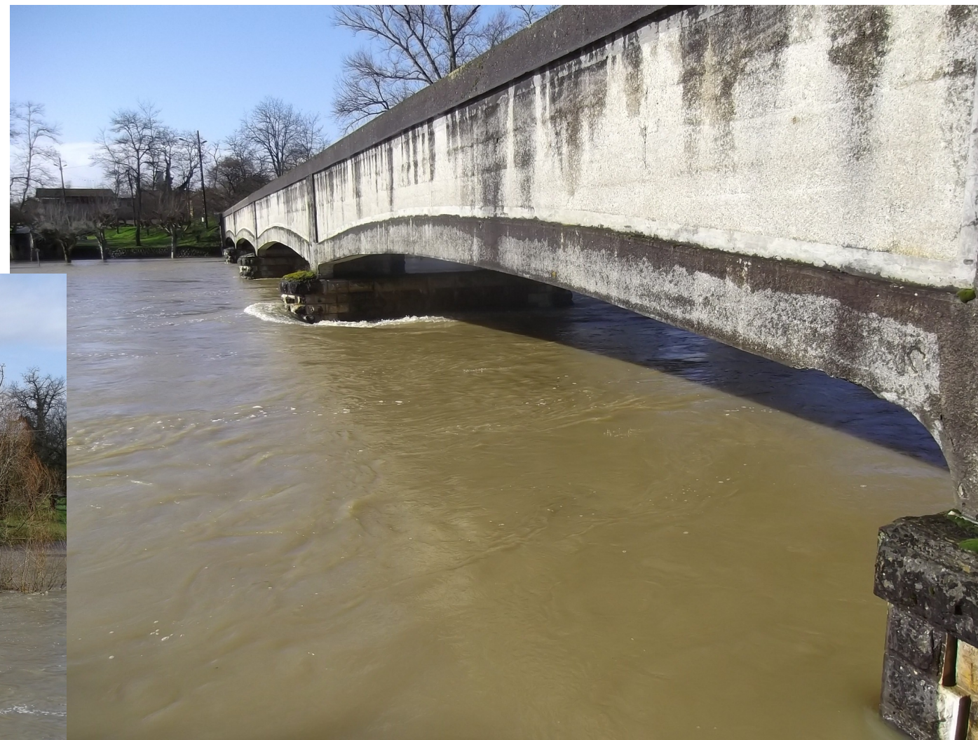
Vue du pont de la station de Cahuzac-sur-l'Adour
