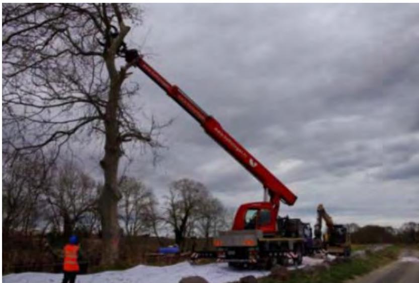
*Photo 13 : Découpe du houppier à l'aide d'un grappin hydraulique (Source : Naturalia - Canal du Midi)*
