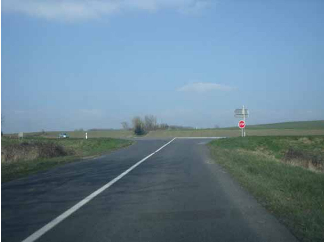
Vue n ° 1 : Carrefour RD 52 / RD 347
