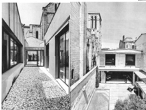
Reconversion d'atelier Bordeaux, Frederik Dain arch.
