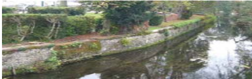
Murs de soutènement des berges de l'Antenne à l'entrée du bourg de Javrezac
