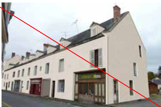
NON ! Le doublage extérieur des façades ne peut pas être envisagé pour des immeubles à façade en pierre.
