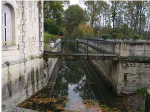
Canal et franchissement à Crozin
