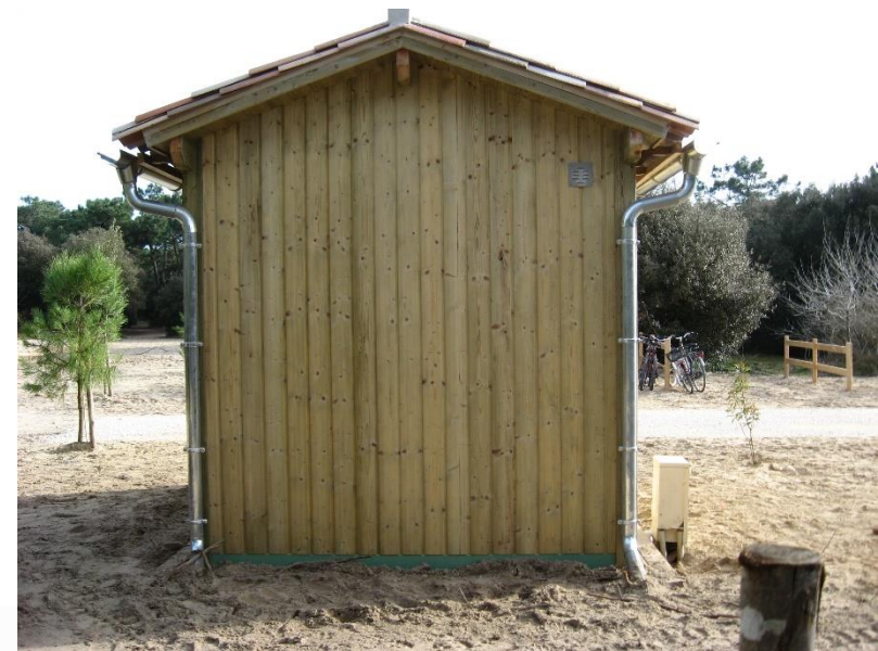
Bardage bois sur toilettes sèches (ex : sur toilettes automatiques à Trousse-Chemise aux Portes-en-Ré)
