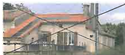
Mauvais d'intégration de panneaux solaires dans une toiture. Deux-Septres
