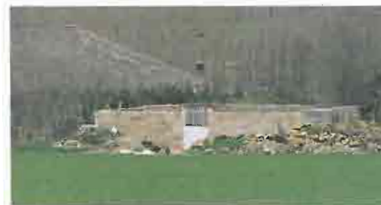
Cimetière privé, rue du Temple - Verrines-sous-Celles
