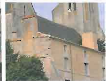
Façade avant du Logis après restauration
