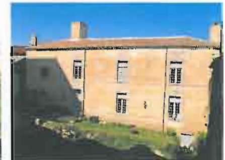
Façade arrière du logis
