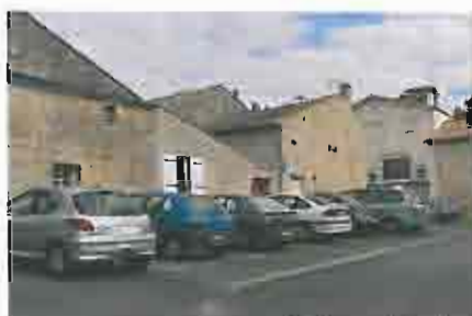
Parking - rue du Blouchaud
