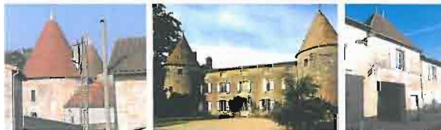
Toitures des tourelles
