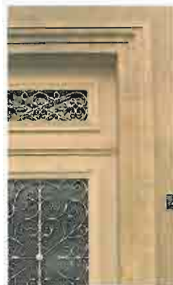
Encadrement de porte en pierre 41, rue Fuite de la Jolie
