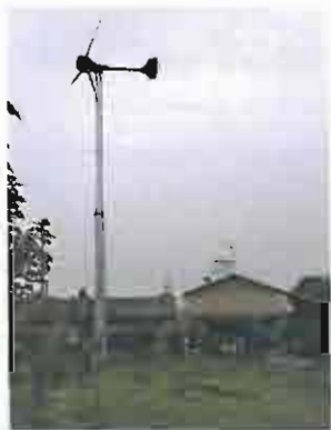
Eolienne domestique à Souvigné (79) Source : La Nouvelle République 11/2010
