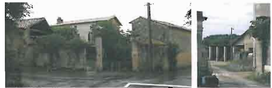
20, chemin des Ecoilers, Verrines
