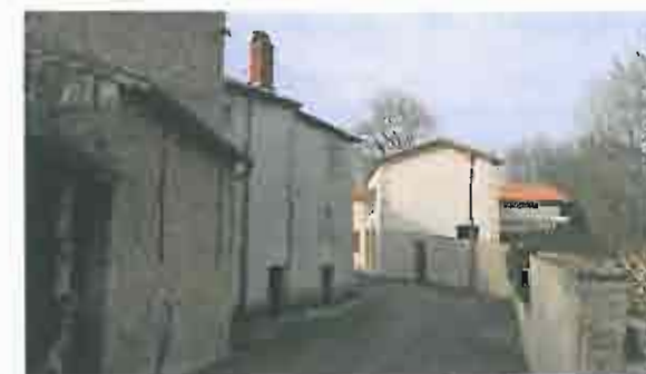
Rue rue sinueuse et sans trottoir
