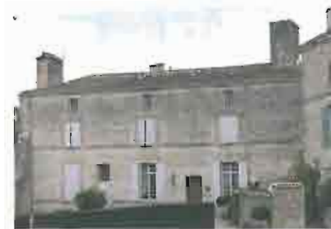
Façade avant du Logis donnant sur la rue des Halles
