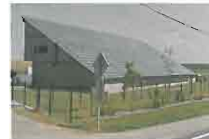
Panneaux solaires intégrés sur l'ensemble de la toiture Bâtiment industriel/agricole, Vouillé (86)
