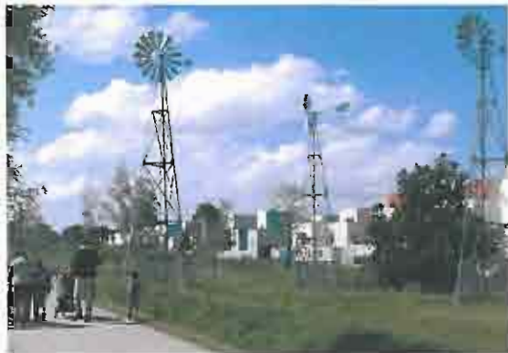
Eoliennes de la Bottière-Chenaie - Nantes L'énergie éolienne permet de renouveler un apport en eau d'arrosage vers les jardins partagés et le parc.
