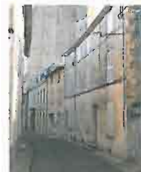
Rue Belle-Image, construction à l'alignement
