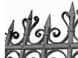
Détail d'une grille, Chemin de la Raudoine, Verrines
