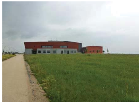
Vue Nord-Ouest du site
