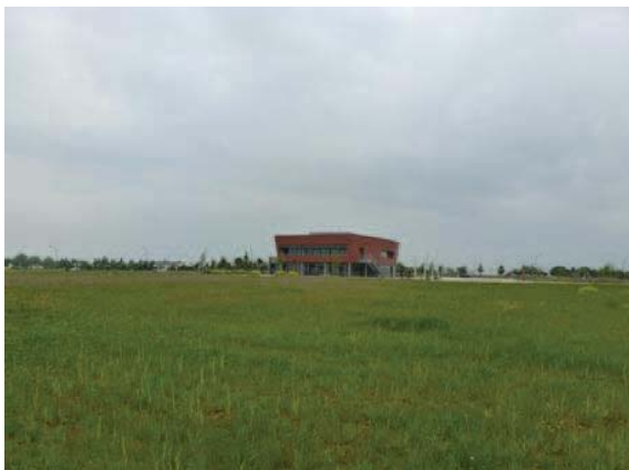
Vue Sud-Ouest du site
