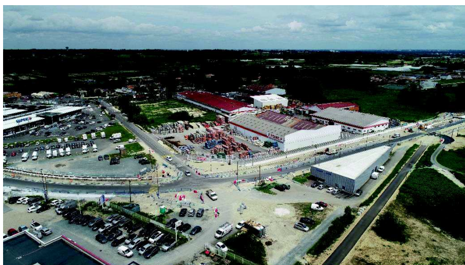
Jardin de Cantinolle avant travaux
