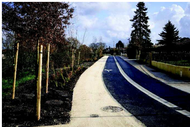
Rue B. Triat après travaux
