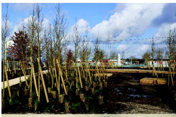
Jardin de Cantinolle après travaux
