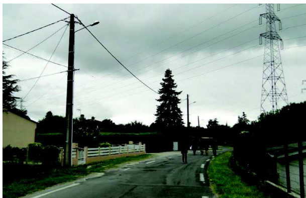
Rue B. Triat avant travaux
