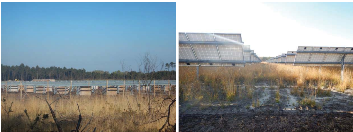
Figure 39 : Vue du parc photovoltaïque depuis le nord du projet (à gauche) et détail des panneaux (à droite) (Source : ENVOLIS, 2017)
