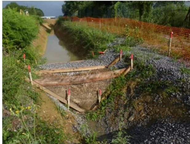
Photo 7 : Exemple d'un filtre à paille - Simethis
