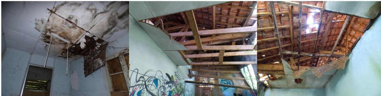
**Fig. 35. Photographies du plancher des combles en mauvais état sur les 2 bâtiments**
