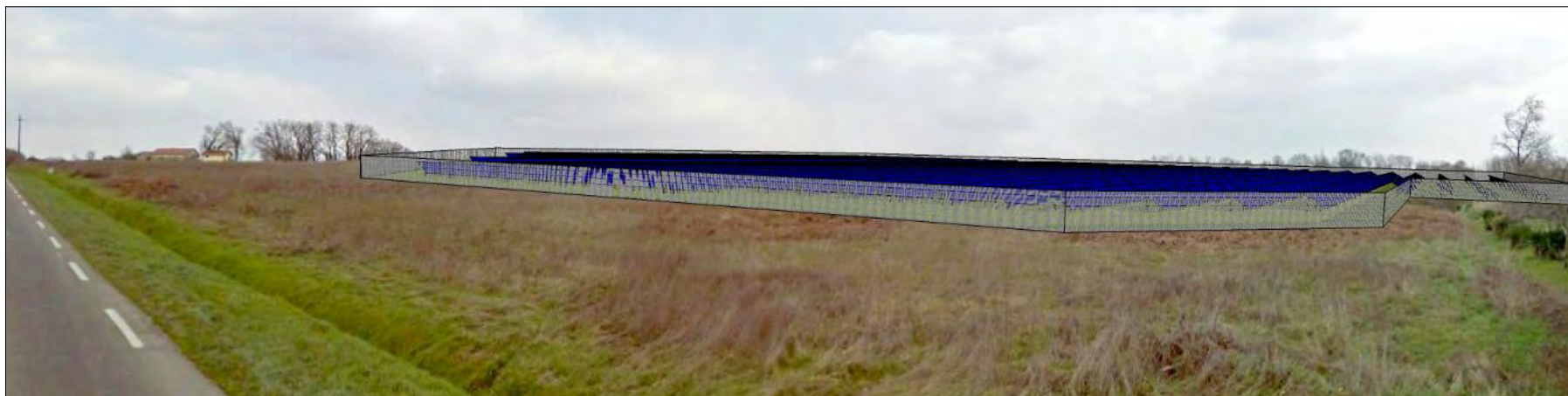
PC6- Insertion sur site
