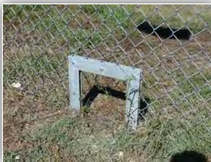
Photo 14 : Exemple d'une trappe pour la petite faune
