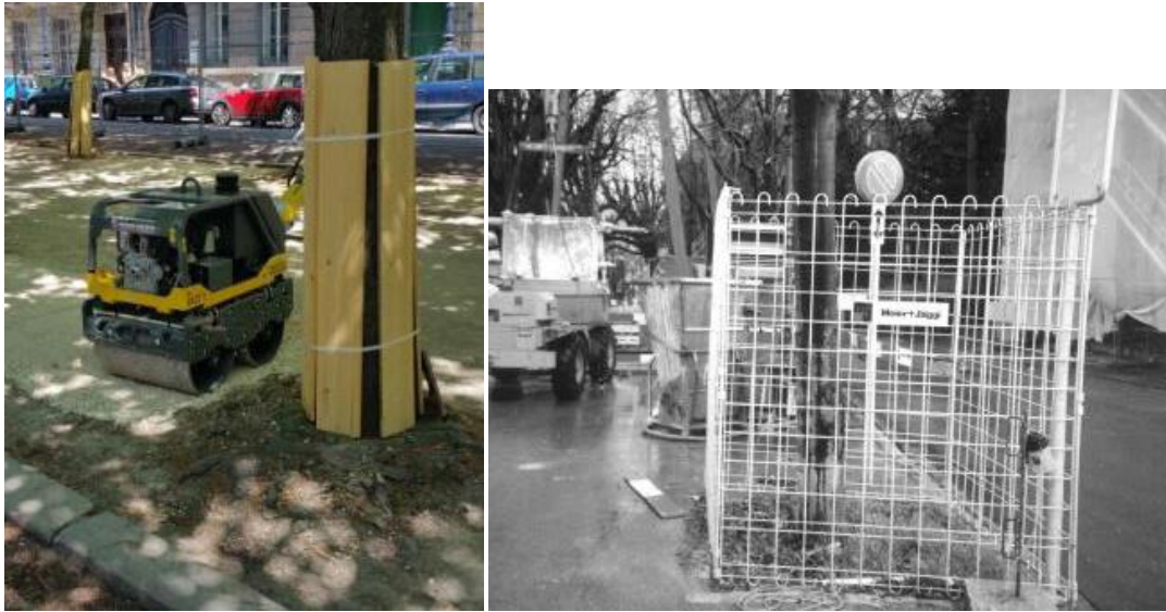
Figure 35 : Exemple de protection du tronc par des planches de bois ou grilles métalliques de plus petite taille pour des zones de travaux au plus proche de l'arbre.
