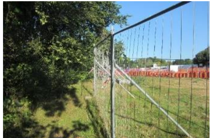
Protection de haie dans le cadre de la création d'un tunnel
