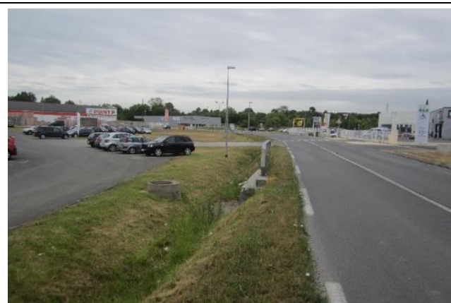
Zone d'activités avenue du Taillan-Médoc
