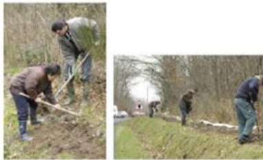
Planter les pieux de bois
