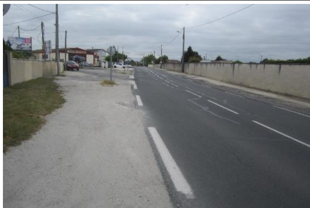
Avenue du Taillan-Médoc le long du cimetière du bourg à Eysines
