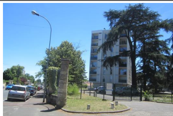
Avenue de la Libération, avec grand cèdre au pied des immeubles
