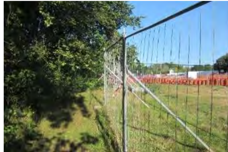
Protection de haie dans le cadre de la création d'un tunnel
