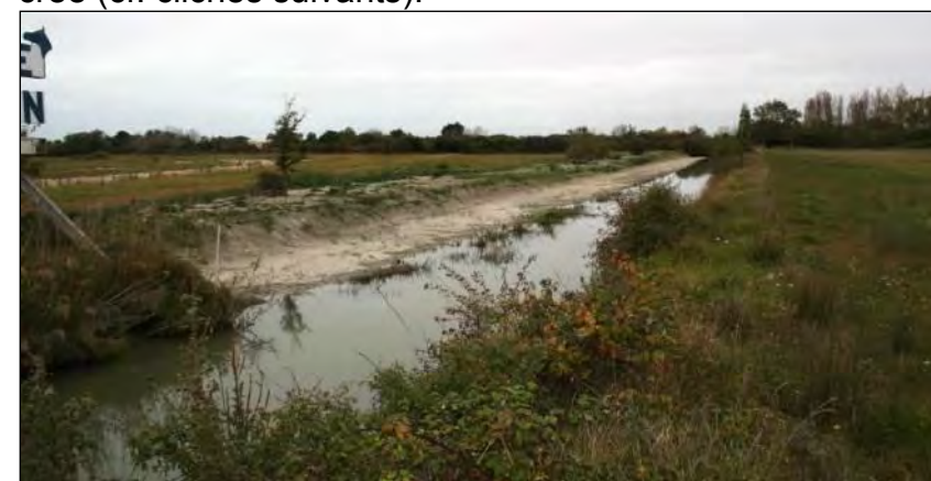
Figure 56 : vue de la banquette peu après sa réalisation (cliché Eau-Mega du 11/10/2011)
