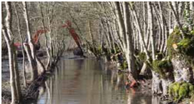
Travaux d'entretien : Curage de fossés et émondage des frênes têtards
