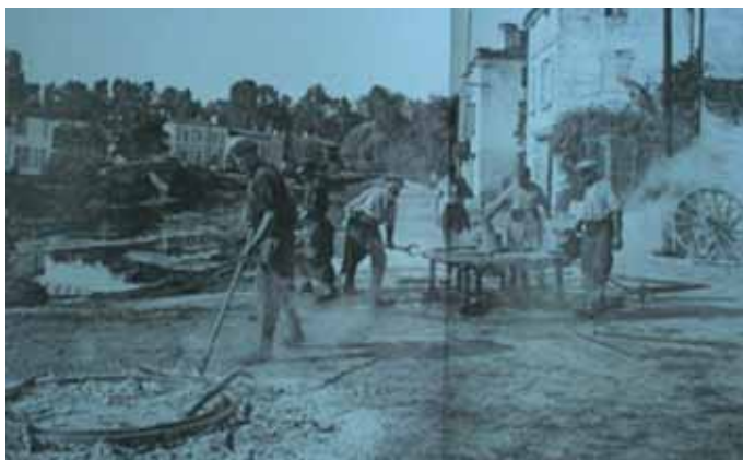
Cerclage des roues vers 1920 au port de la Coutume (Altemeyer, Coursaud, .année, p;X)
