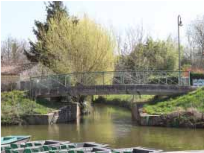
Vue depuis le bourg: le pont sur le canal de la Repentie tel un portail d'accès vers la «Venise Verte»
