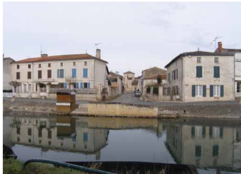
3 - Rue de l'Eglise
