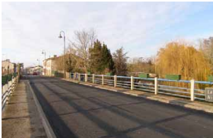
RD1 - Franchissement de la Sèvre sur la commune de Coulon
