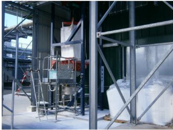
Chargement de poudres RE25
