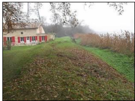
Photographie 9: Digue DI.24.08
