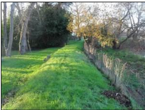
Photographie 8: Digue DI.24.06.2
